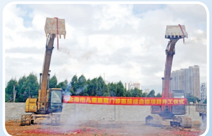
2016年6月22日，北海市儿童医院门诊医技综合楼项目开工仪式 区委宣传部 供
